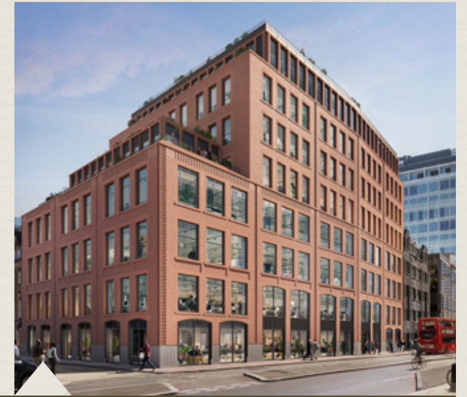
FOLGATE BUILDING LONDON E1
